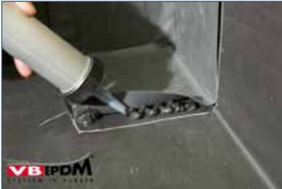
Bild 61. Formteilabdichtung mit VB-9510.
