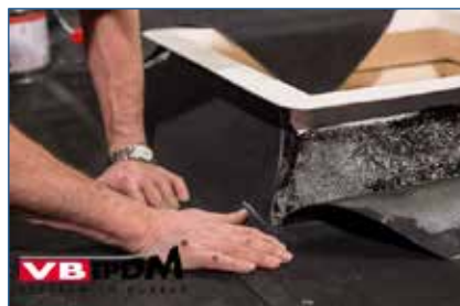
120. Andrücken der verklebten Flächen.
