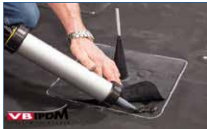
Bild 108. Abdichten der Überlappung.
