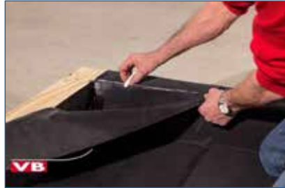
Bild 38. Dachrand anzeichnen auf die EPDM Folie.
