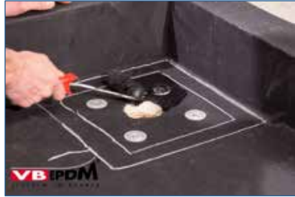
143. KS-100 Verklebung der Membrane.
