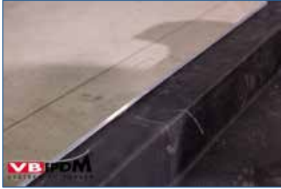
Bild 33. Fertig verklebter Attika- und Randbereich.
