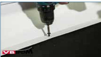
130. Mechanische Befestigung der Lichtkuppel.
