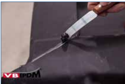
Bild 51. VB-9510 Reste mit einer Spachtel entfernen.
