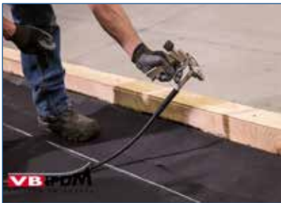
Bild 34. KS-1000 am Randbereich aufbringen.
