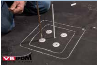
Bild 105. Mechanische Membranbefestigung.
