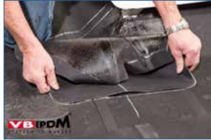
124. Montage des verklebten Formteils.
