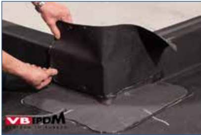
Bild 82. EPDM-Streifen auf das Formteil montieren.
