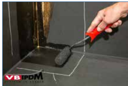
Bild 56. KS-100 Membranverklebung.
