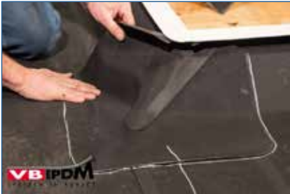
125. Montage des verklebten Formteils.
