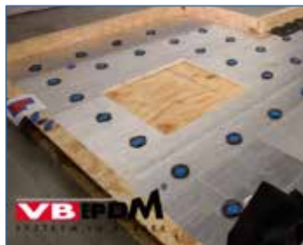
Bild 5. Thermofix® Elemente verschraubt.
