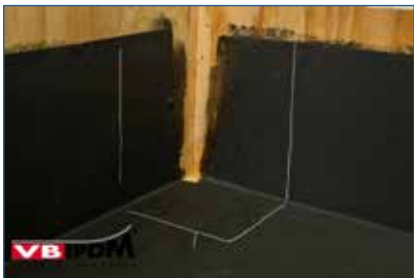
Bild 55. Position des Formteils mit Kreide festlegen.
