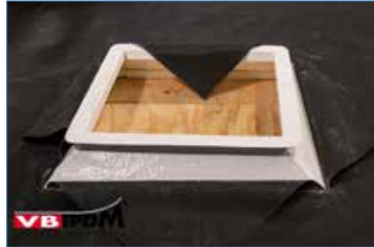
114. Zurückfalten der EPDM Membranseiten.
