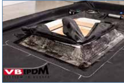
133. KS-100 verklebtes Formteil.
