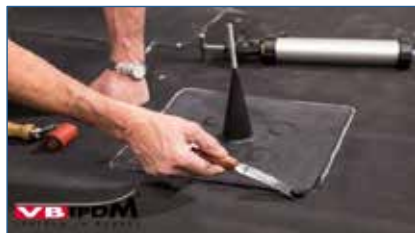
Bild 110. Entfernen der VB-9510 Reste.
