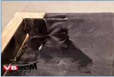
Bild 37. Verklebter Attika- und Randbereich.
