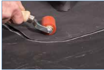
Bild 23. Überlappung im Kleber Bereich anrollen.
