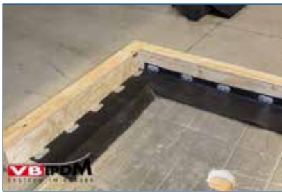
Bild 36. Armierter Attikabefestigungsstreifen.
