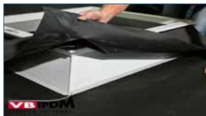
131. Ausrichten des Formteils.
