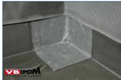
Bild 64. Fertige Innenecke.
