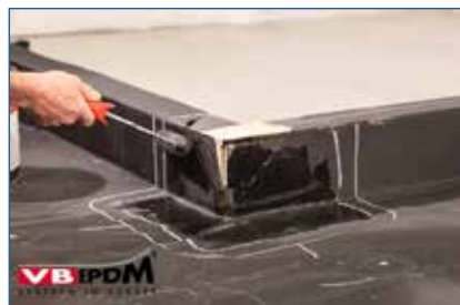
Bild 72. KS-100 Membranverklebung.
