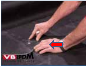
Bild 6. Schraublochmarkierung.
