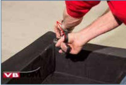
Bild 47. EPDM Folie diagonal einschneiden.
