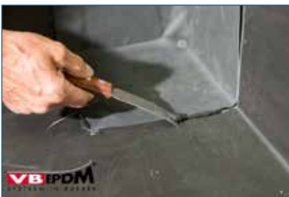
Bild 63. Entfernen der VB-9510 Reste.
