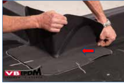
Bild 74. Formteil plazieren. Hohlräume vermeiden.
