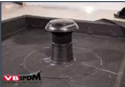
Bild 102. Fertig abgedichtete Durchdringung.
