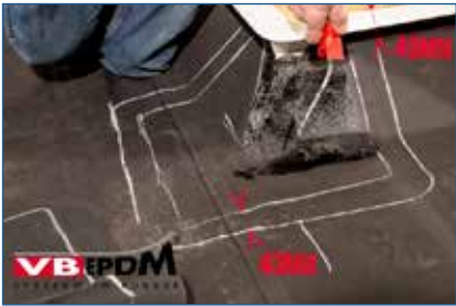
123. KS-100 Verklebung der EPDM Membrane.
