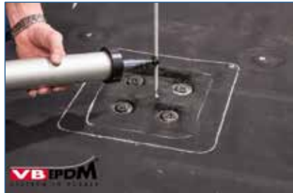
Bild 106. VB-9510 Abdichtungsmasse aufbringen.
