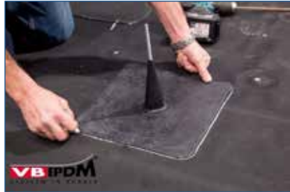
Bild 104. Formteil anzeichnen.
