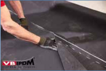
Bild 22. Überlappung schliessen.
