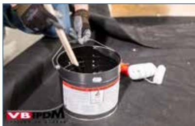
Bild 28. Durchrühren des KS-100 Kontaktklebers.
