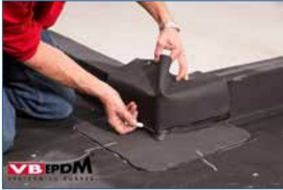
Bild 80. Oberes Formteil anzeichnen.
