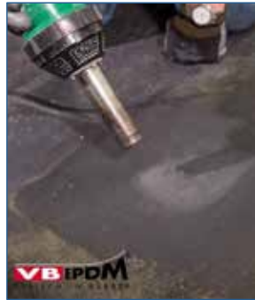
150. Heißluftgerät verwenden.
