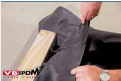
Bild 41. EPDM-Folie in die Ecke falten.
