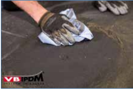
149. Abtrocknen des beschädigten Bereiches.
