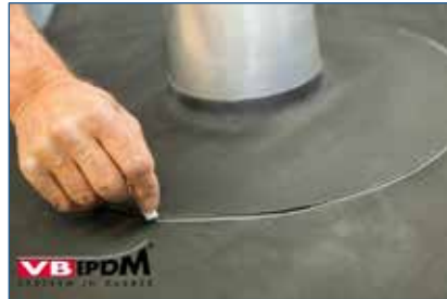
Bild 87. Formteil anzeichnen.
