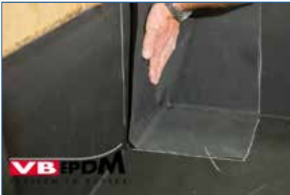
Bild 59. Formteil mit der flachen Hand andrücken.
