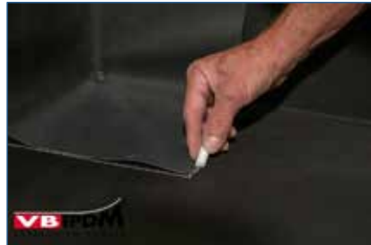
Bild 54. Anzeichnen Inneneckformteil.
