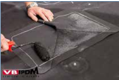
Bild 71. KS-100 Formteilverklebung.
