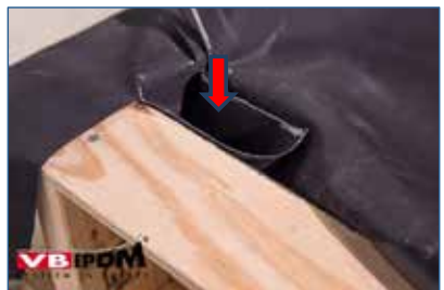
Bild 44. Materialüberschuss bildet eine „Tasche“.
