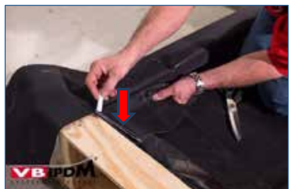
Bild 42. Dachrand auf die EPDM-Folie anzeichnen.
