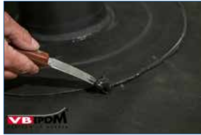
Bild 101. Entfernen der VB-9510 Reste.
