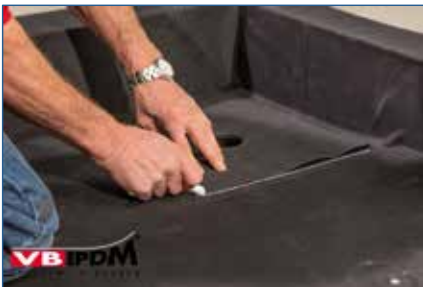
140. Position des Wasserablaufs anzeichnen.
