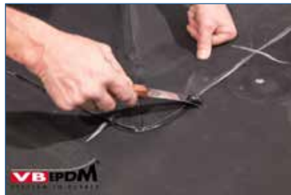
139. Entfernen der VB-9510 Reste.
