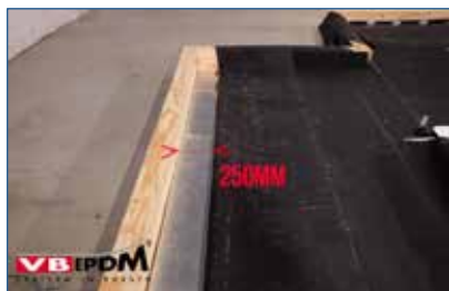
Bild 27. Zurückgefaltete EPDM Membrane.
