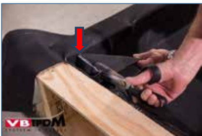
Bild 43. Einschnidung bis 1 cm vor die Ecke.
