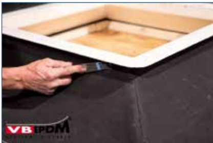
136. Dichtfalten des Formteils.
