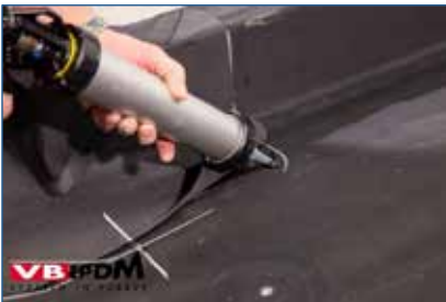
Bild 77. Abdichten der Überlappung.
