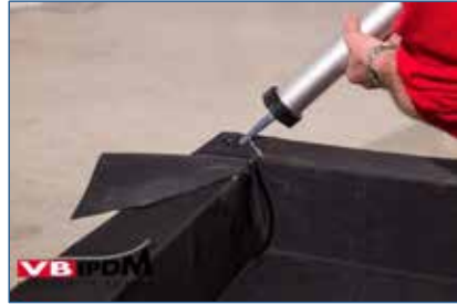
Bild 48. Die Horizontalseite mit VB-9510 abdichten.
