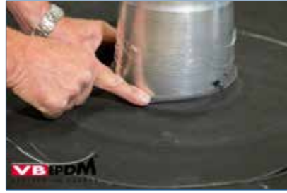
Bild 93. Formteilstulpe zurückfalten.
