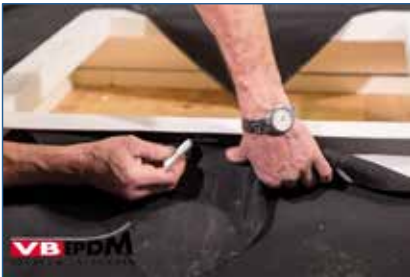
115. Anzeichnen der Aufstandhöhe.
