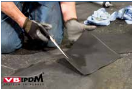
151. Anfertigung eines Reparaturstücks.
