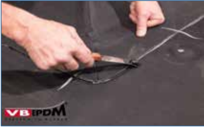
129. Entfernen der VB-9510 Reste.
