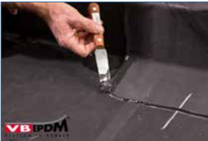
Bild 79. Entfernen der VB-9510 Reste.
