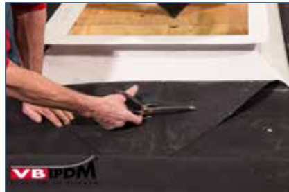
116. Abschneiden der EPDM Membranseiten.
