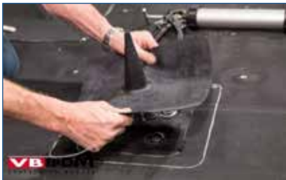
Bild 107. Formteilmontage.
