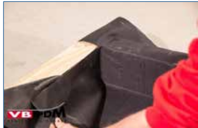
Bild 40. EPDM Folie in die Ecke falten.
