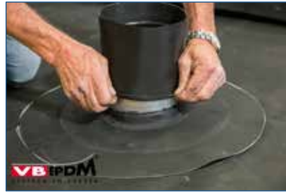
Bild 95. Formteil anbringen.
