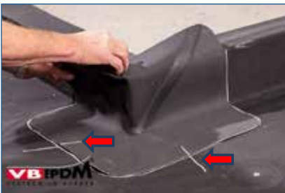
Bild 69. Formteil plazieren und anzeichnen.
