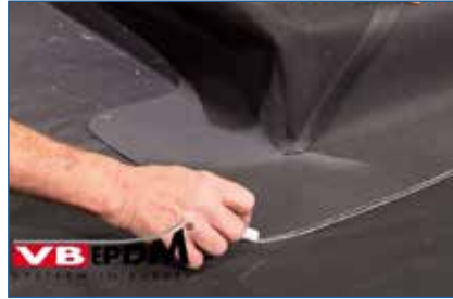
122. Formteil auf die Membrane anzeichnen.
