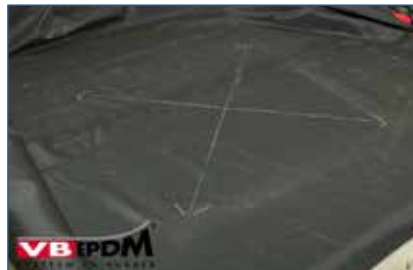
112. EPDM Membrane kreuzweise einschneiden.
