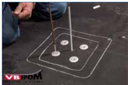
105. Mechanisch bevestigen membraan.
