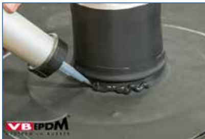
97. Afdichten met VB-9510 langs onderzijde.
