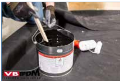
28. Roeren contactlijm KS-100.
