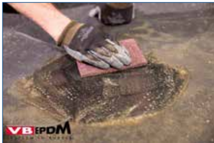
159. Reinigen reparatieplek.
