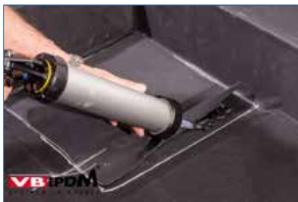
145. Afdichten slabbe met VB-9510.
