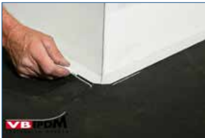
111. Aantekenen doorbreking.
