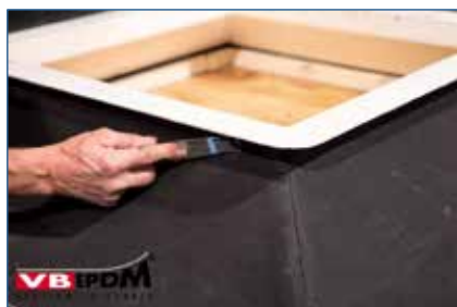
136. Dichtklappen manchetrand.
