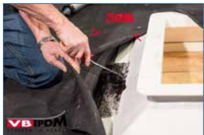
117. Inlijmen lichtkoepelopstand.
