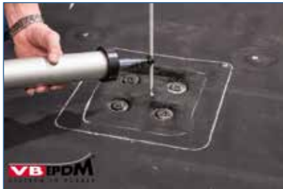
106. Aanbrengen VB-9510 op doorbreking.
