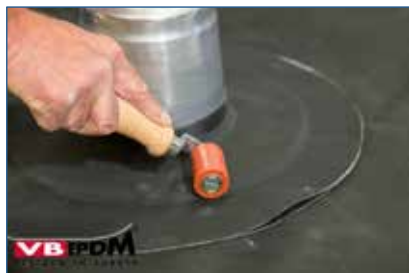
92. Aanrollen gelijmd deel.
