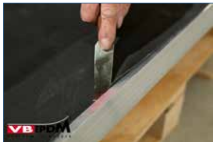
155. Dichtklappen kitnaad met kitlepel.
