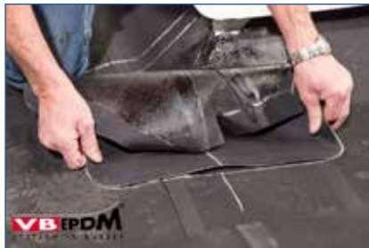
124. Plaatsen prefab hoekstuk.
