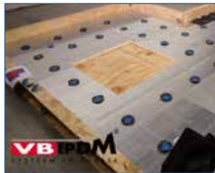
5. Thermofix® elementen bevestigd.
