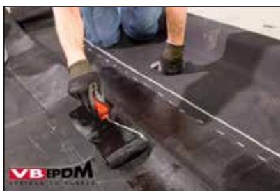
21. Aanbrengen KS-100 contactlijm.
