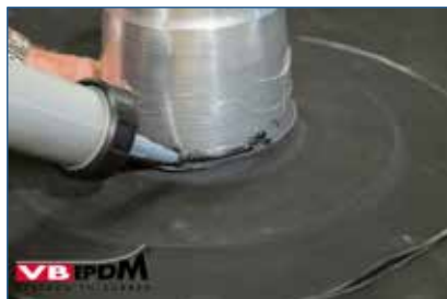
94. Afdichten binnenrand met VB-9510.
