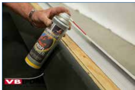
147. Ontvetten aluminium daktrim.
