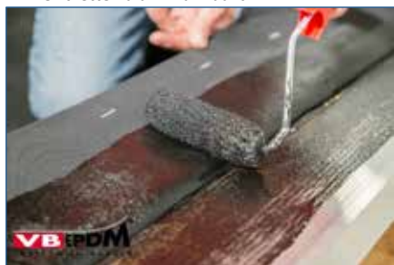
149. Inlijmen daktrim + membraan.
