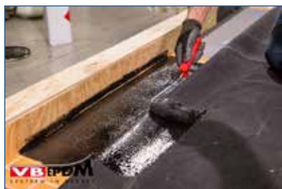
29. Aanbrengen contactlijm KS-100.
