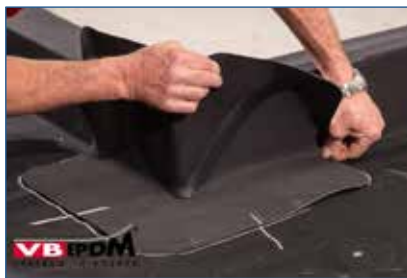
74. Aanbrengen prefab hoekstuk.
