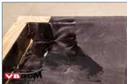
37. Ingelijmde dakopstand t.p.v. binnenhoek.
