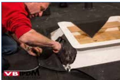
118. Inlijmen lichtkoepelopstand met lijmrije zone.
