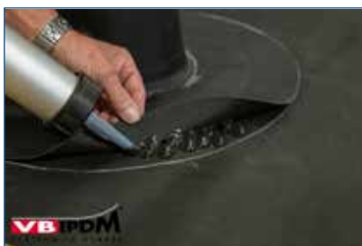
99. Afdichten met VB-9510 in het dakvlak.
