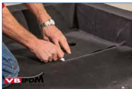
140. Aantekenen positie VB-drain.
