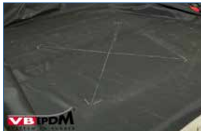
112. Inknippen membraan ( Let op valbeveiliging! ).
