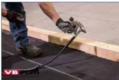
34. Aanbrengen spuitlijm.
