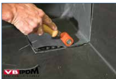
62. Het gekitte deel aanrollen met siliconenroller.
