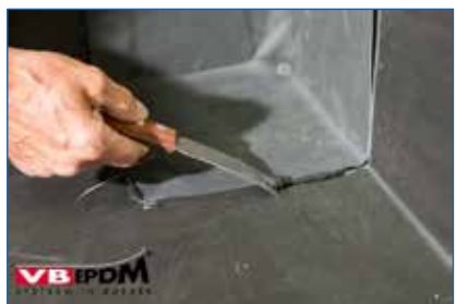
63. Uitkomende overtollige rubberkit verwijderen.
