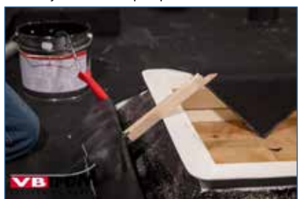
119. Gescheiden drogen van lijm.
