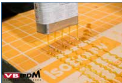
17. Aanbrengen KS-150 lijm.
