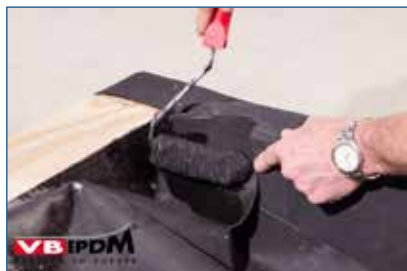
45. Inlijmen binnenzijde hoek.
