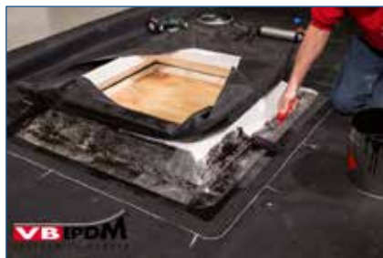
132. Inlijmen manchet + lichtkoepelopstand.
