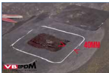
164. Inlijmen reparatieplek en reparatiestuk.
