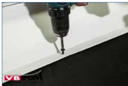
130. Lichtkoepelopstand mechanisch bevestigen.
