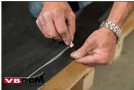
152. Aantekenen af te knippen deel.
