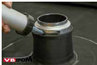
98. Afdichten met VB-9510 langs bovenzijde.
