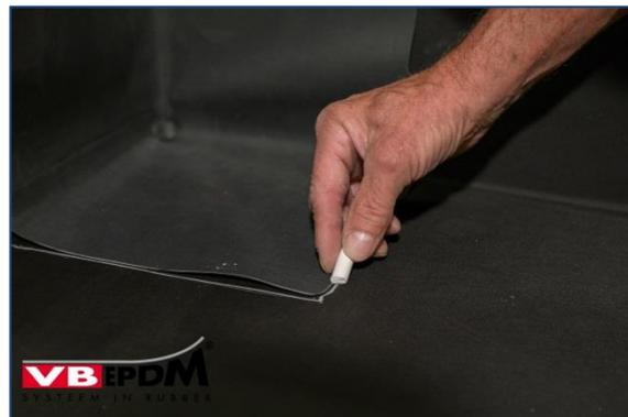
54. Mark sealing sleeve edge on membrane.
